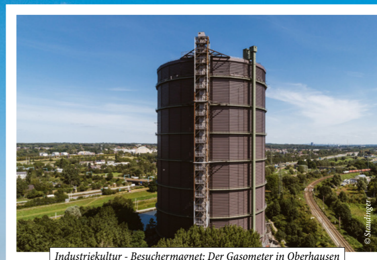
Industriekultur - Besuchermagnet: Der Gasometer in Oberhausen
